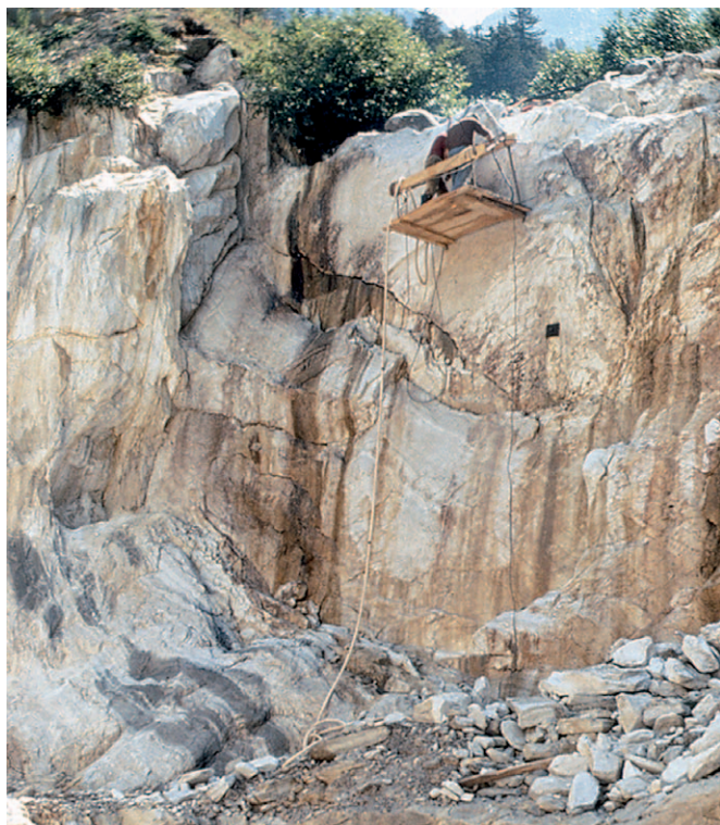
Sicherungsarbeiten an der hohen und steilen Südwand der Grube Lengenbach im Sommer 1972.
